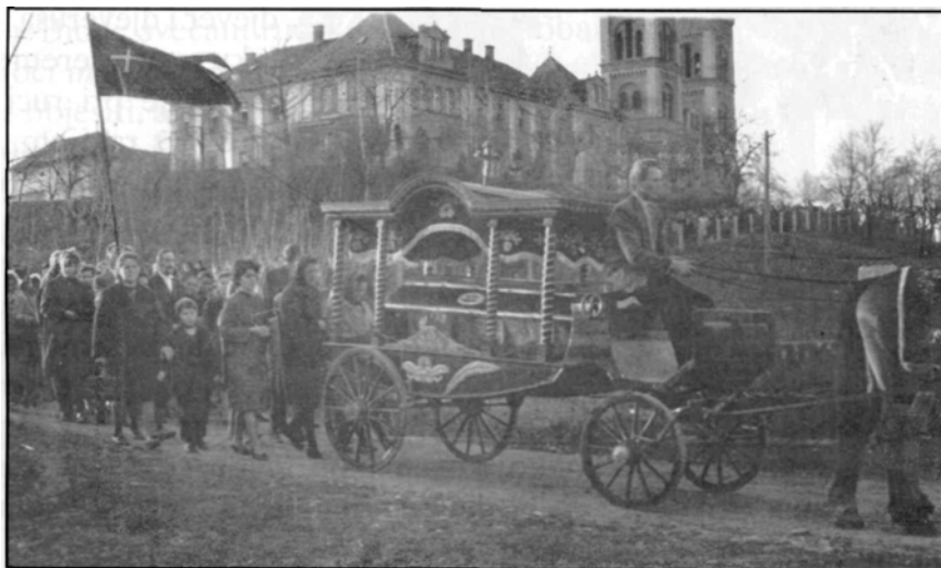
Sprovodfra Ante Hrvata 10. ožujka 1967. na Petrićevcu na fra Bosiljka Gubića, dok je spavao u krevetu. Željeznička stanica u Ramićima tako je bila oštećena potresima, da je morala biti ispražnjena, a željeznički personal se nastaniti u vagonima. 35
