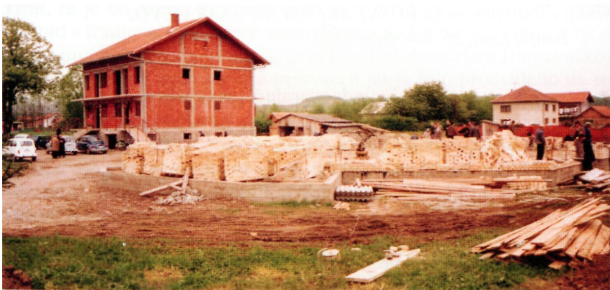
Župna kuća je pod krovom, a gradnja crkve na početku
