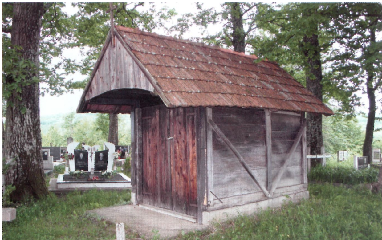
Drvena kapelica na groblju Suvaje
