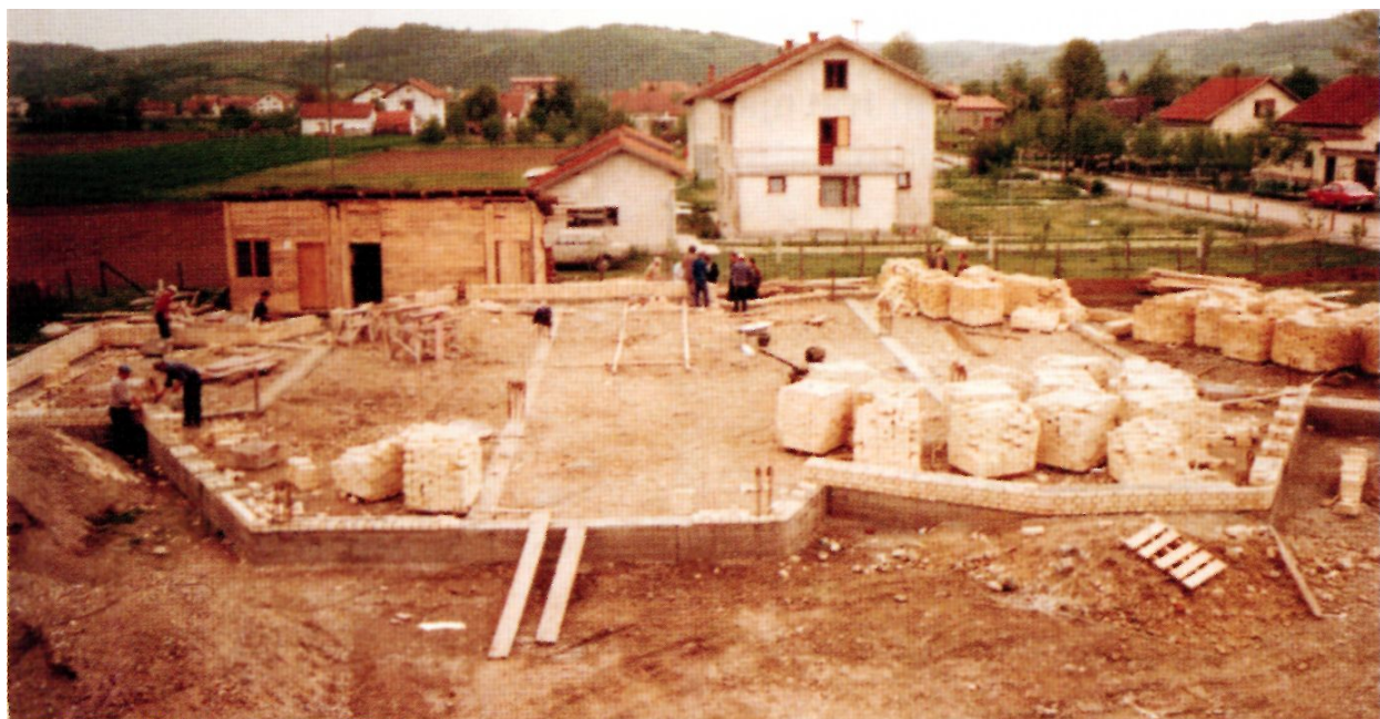
Početak gradnje župne crkve 1984.
