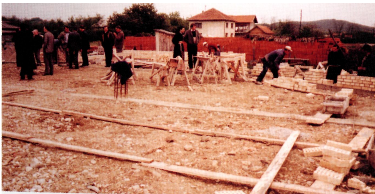
Svećenici na gradilištu crkve 1984. godine
